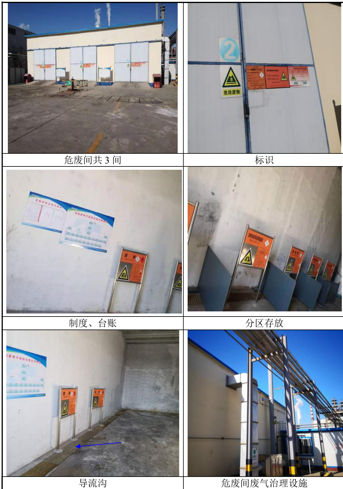
图 3.3-11 危废间现状情况
